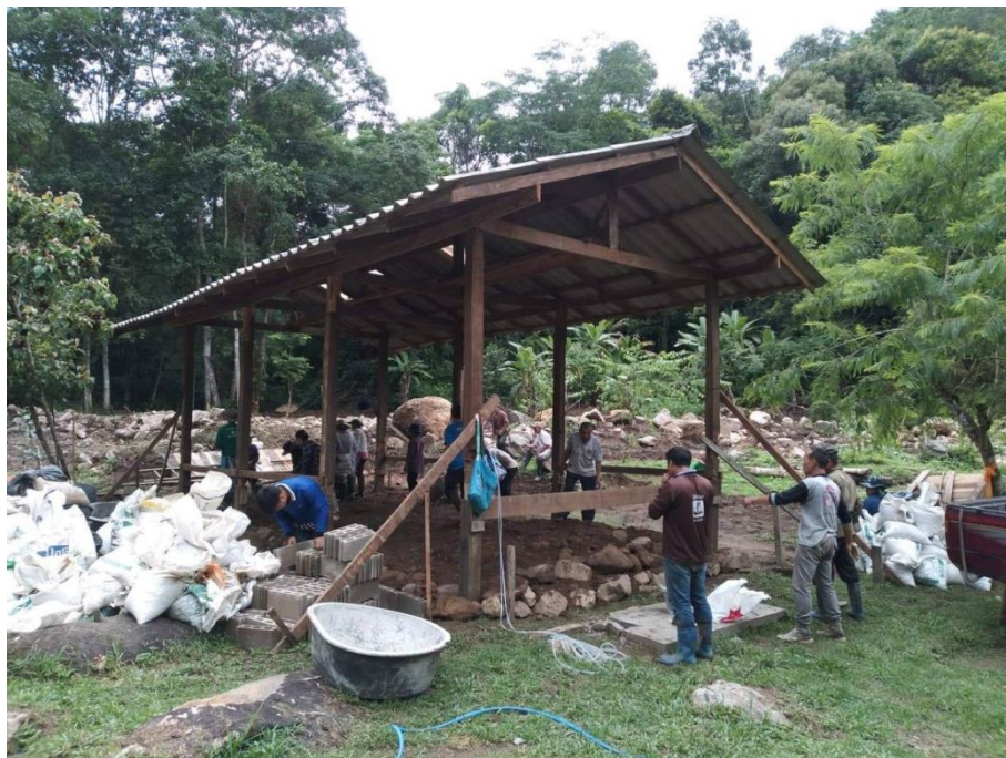
ภาพที่ 4.43 (ต่อ) : การดำเนินการก่อสร้างอาคารชั่วคราว
