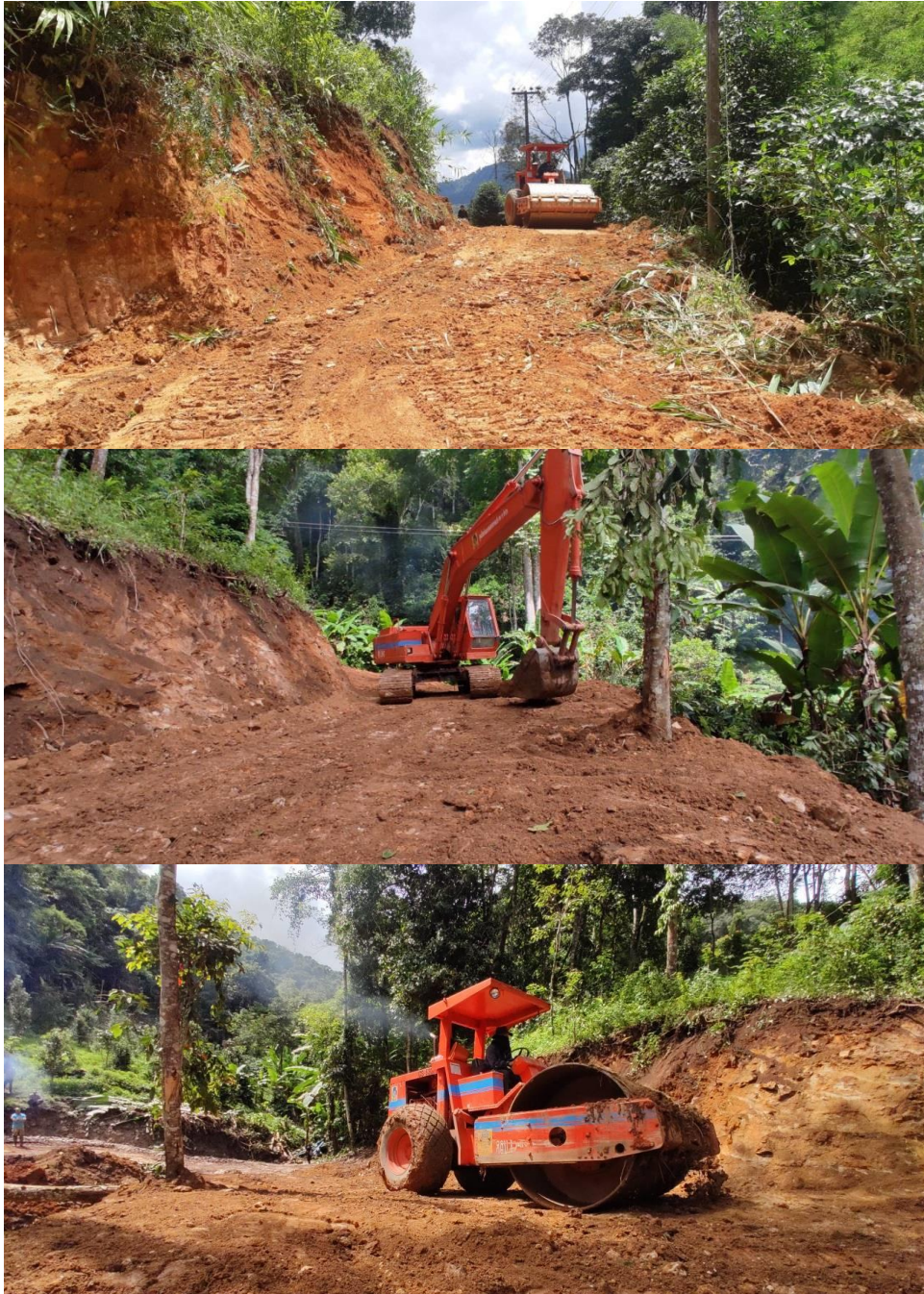
ภาพที่ 4.42 : การปรับพื้นที่บริเวณที่จะจัดตั้งศูนย์วิจัยฯ
